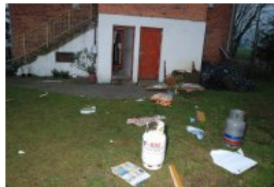
Budynek po wybuchu gazu
